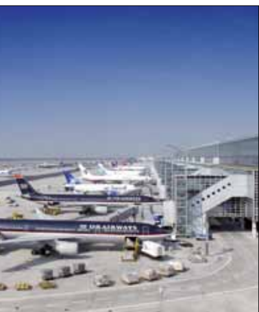
Repülőtér, Frankfurt Airport, Frankfurt
